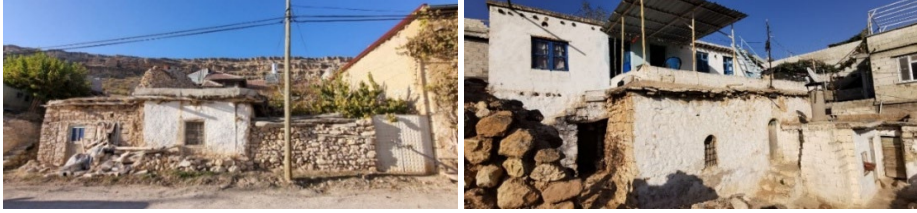
Şekil 11a-b. Ev-1’e ait ön görünüş (sol); Ev-2’ye ait ön görünüş (sağ) (Yazar(lar) arşivinden, 2022).
