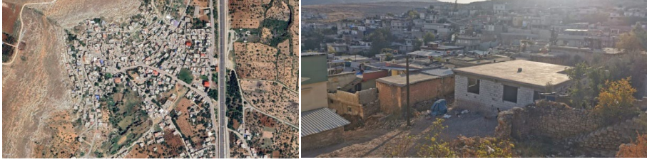
Şekil 4a-b. Dülük Köyü haritası (sol) (URL-2); Dülük Köyü genel görünümü (sağ) (Yazar(lar) arşivinden, 2022).
