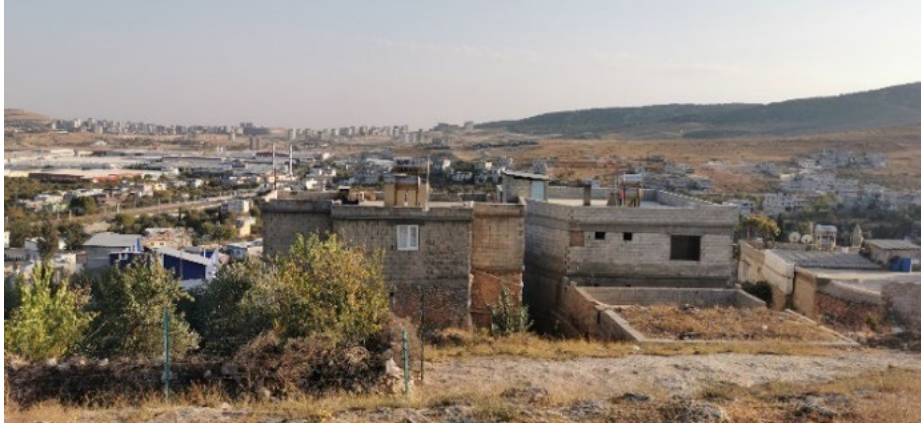
Şekil 10. Yeni yapılaşma içerisinde kalmış, muhdes kat eklenen topografyayla uyumlu geleneksel konutlar (Yazar(lar) arşivinden, 2022).
