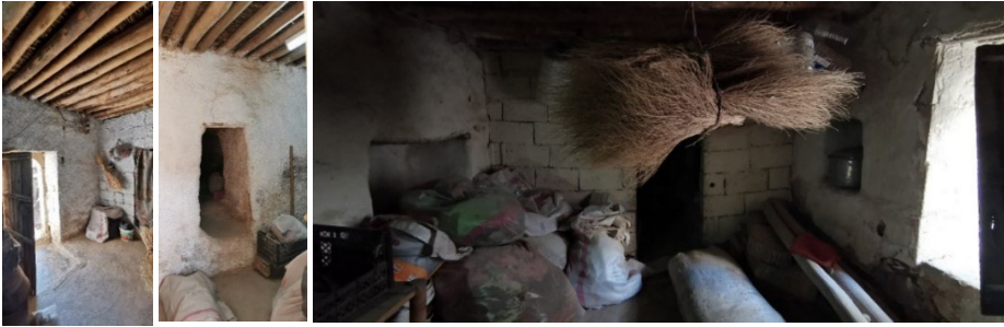
Şekil 15. Z-1 oda görünümü (sol) Z-2 mekanına giriş kapısı (orta) Z-2 Mutfak/Kiler-Duvarı yer alan küçük nişler ve kuzeye açılan küçük pencere görünüşü (sağ), (Yazar(lar) arşivinden, 2022).
