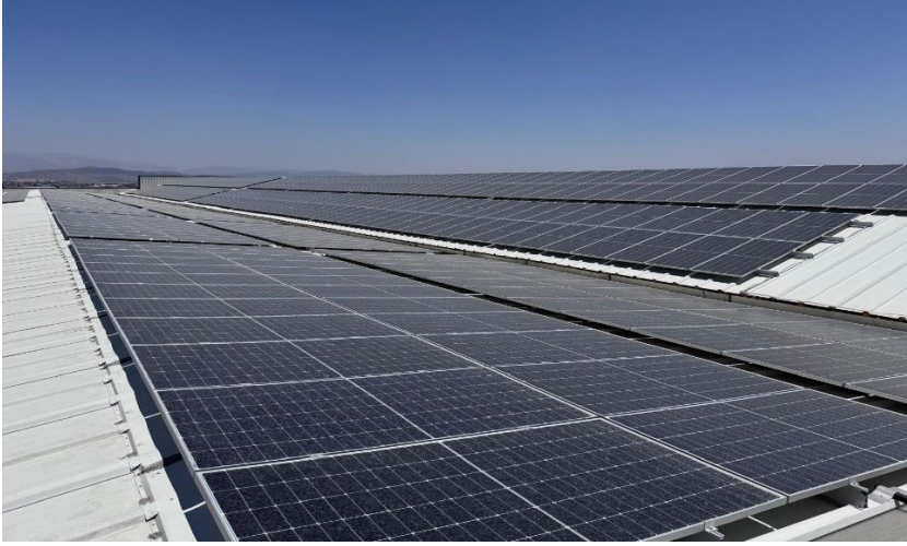
Şekil 2. Santrale Ait Genel Görünüm
