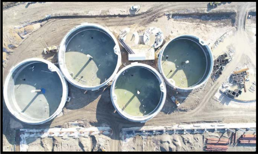
Foto 3: Körpınar Biyogaz Üretim Tesisi İnşaat Sahası Kuş Bakışı Görünüm (Ana Çürütücüler)
