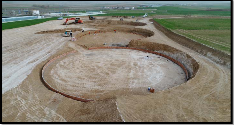
Foto 2: Körpınar Biyogaz Üretim Tesisi İnşaat Sahası Kuş Bakışı Görünüm (Ana Çürütücüler)
