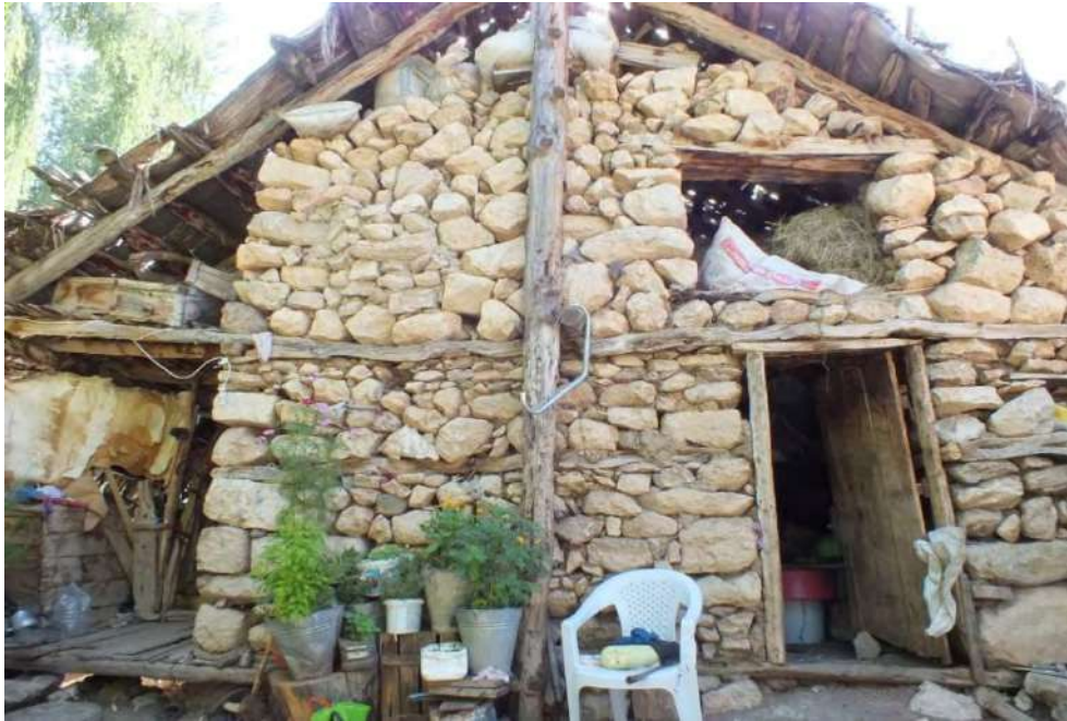
Fotoğraf 2.73. Zemin Katı Ev ve Depo, Çatı Katı İse Samanlık Olarak Düzenlenmiş Yayla Meskeni (Kildenli Yaylası/Yuva Mahallesi)
