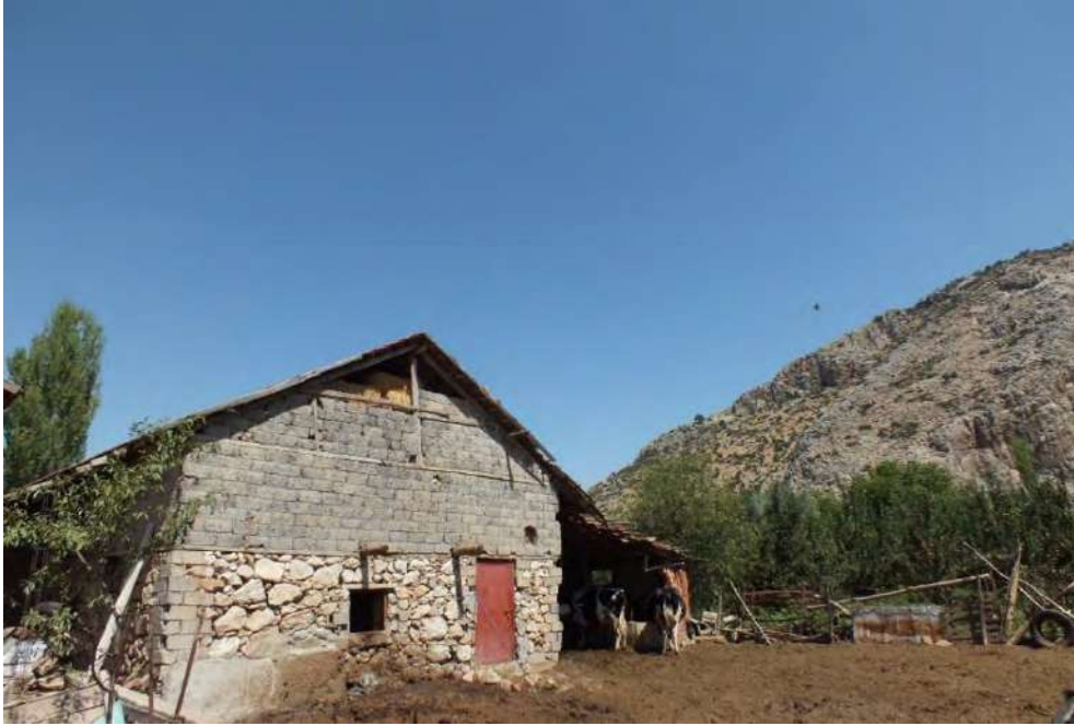
Fotoğraf 2.74. Birinci Katı Ahır, Az Daha Yüksek Yapılmış Çatı Katı Samanlık Olan Bir Mesken (Geçit).
