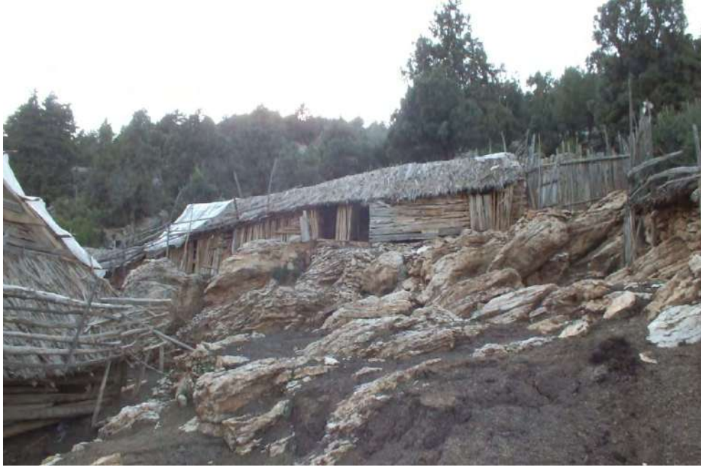
Fotoğraf 2.76. Çatı Örtü Gereci Olarak Kamış Kullanılmış Hayvan Barınakları (Kaynarca Yaylası)
