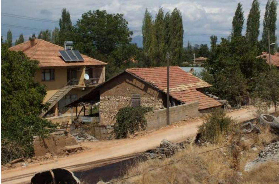
Fotoğraf 2.85. Çatıların Aşağıya Doğru Uzatılması Onların İşlevselliğini Arttırmıştır.
