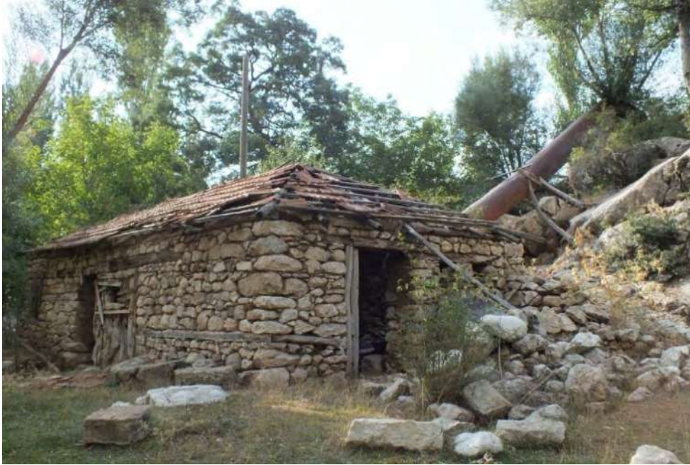
Fotoğraf 3.33. Macun Değirmenköy Mahallesi'ne Adını veren Metruk Değirmen.
