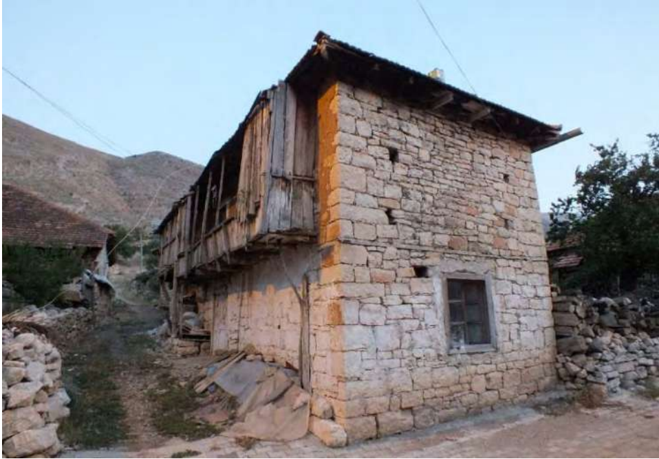
Fotoğraf 2.80. Ovacık Mahallesi'nde İki Katlı Taş Mesken.
