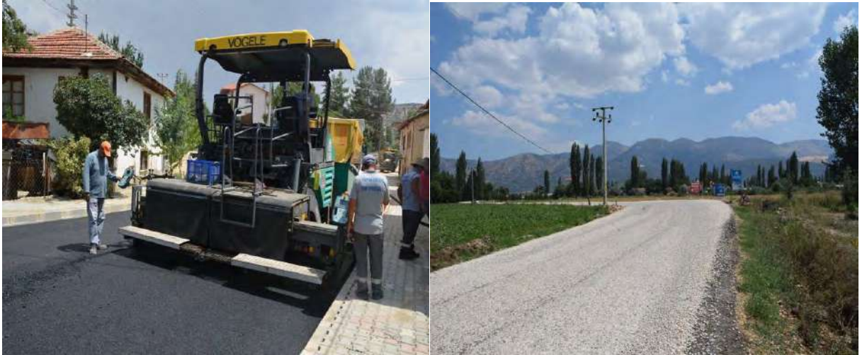
Fotoğraf 3.46. Elmalı Belediyesi Yol Yapım Çalışmaları.
