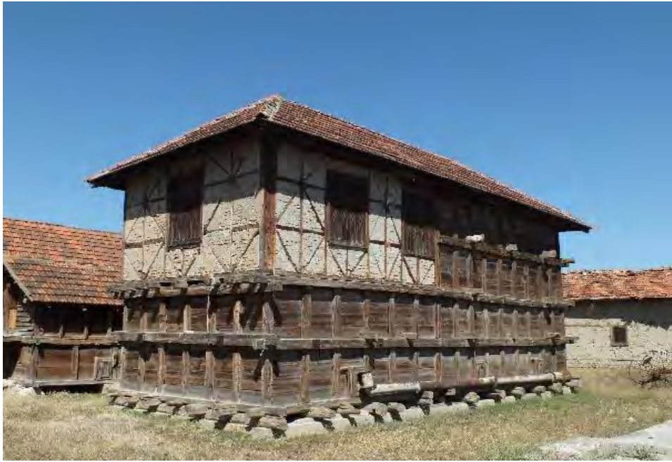
Fotoğraf 2.83. Beyler Mahallesi’ndeki Ambar Evlerden Bir Görünüm.
