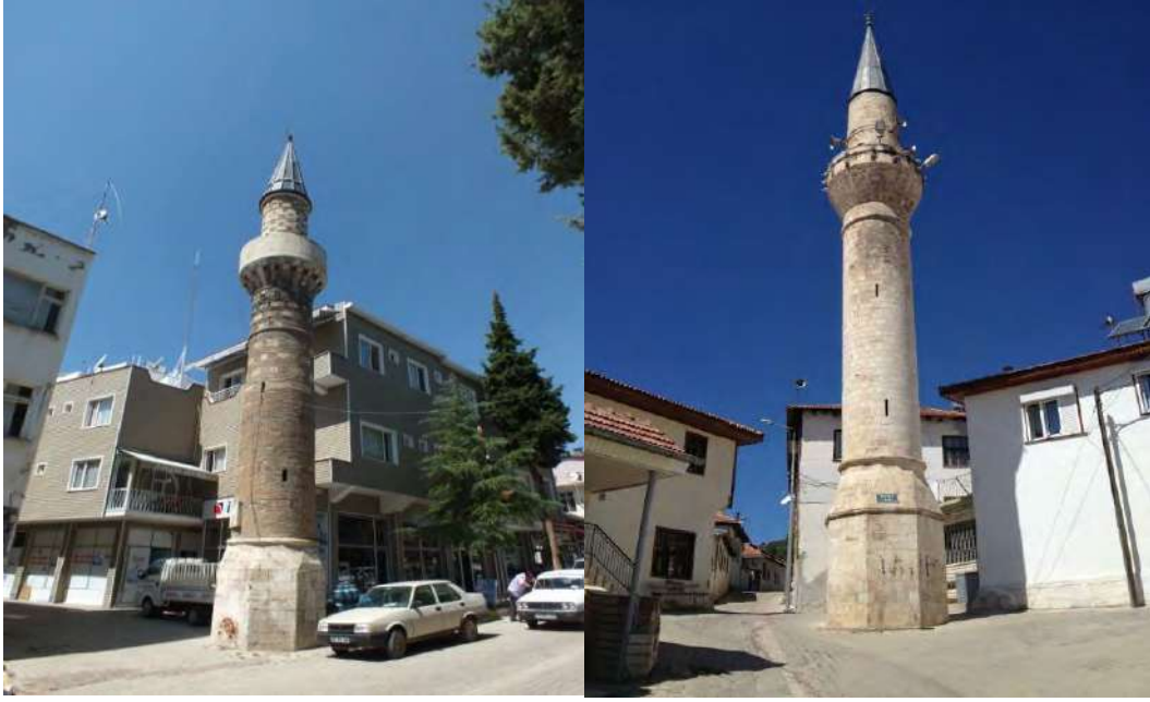
Fotoğraf 3.61. Camiatik Cami Minaresi (Solda) İle Kütük Cami Minaresi Yol Çalışmaları Nedeniyle Yol Üzerinde Kalmışlardır.
