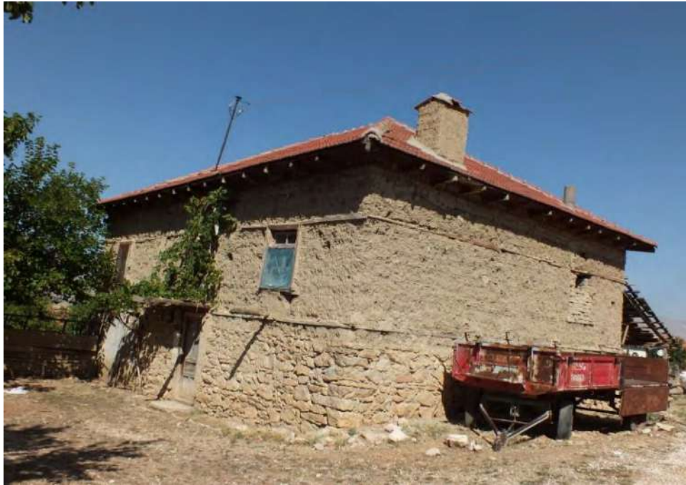
Fotoğraf 2.84. Yüksek Taş Temel, Kerpiç Evleri Selden Koruduğu Gibi Farklı Amaçlar İçin Kullanılan Ayrı Bir Bölüm Özelliği de Kazandırmıştır (Karaköy).
