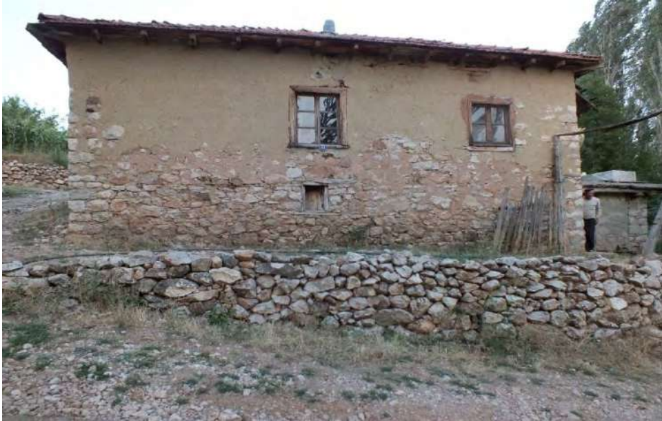
Fotoğraf 2.67. Zemin Katta Aktarma Penceresi Olan Kır Meskeni.
