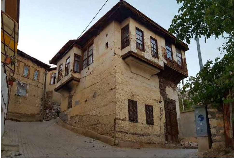
Fotoğraf 2.89. Tarihi Elmalı Evlerinde Kerpiç, Ahşap ve Taş Malzeme Birlikte Kullanılmıştır.
