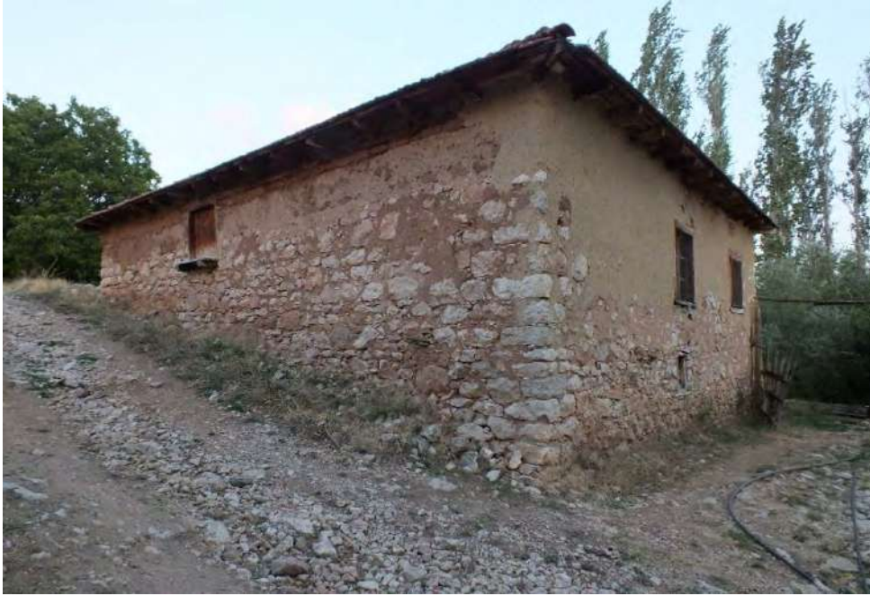
Fotoğraf 2.81. Hacıyusuflar Mahallesi'nde Topografyaya Uygun Olarak İnşa Edilen İki Katlı Taş Mesken.
