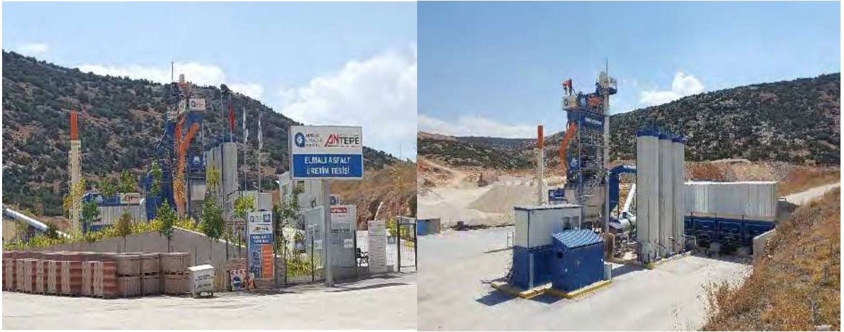
Fotoğraf 3.41. Tesis, Antalya'nın Batı İlçelerinin Asfalt İhtiyacını Karşulamaktadır.
