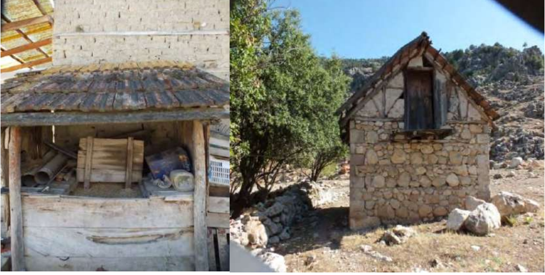
Fotoğraf 2.87. Basit Tarzda İnşa Edilen Tahıl Ambarı (Eymir), Taştan Yapılmış Tahıl Ambarı (Kuzuköy)
