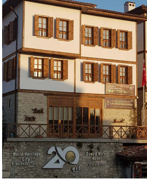
Fotoğraf 21: Safranbolu Kültür ve Turizm Vakfı Binası (Bölükbaşı 2019)
