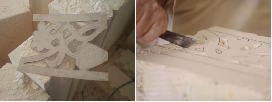
Şekil 3.10: Küçük blokların şablonlarla işaretlenmesi ve taş işçiliği.
