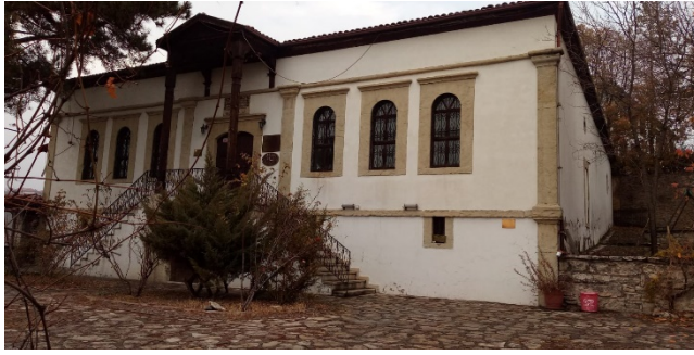
Fotođraf 30: Eski Cezaevi Binası. (Blkbařı 2019)
