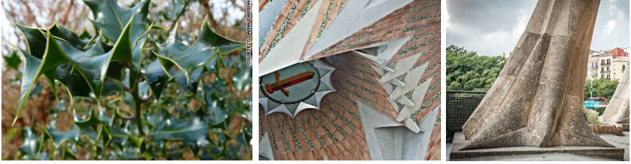
Şekil 10. Doğada yer alan Hiperbolik geometriler (URL-17) ve Sagrada Familia kilisesi hiperbolik yüzeyler ve parabolik ayaklar (URL-18)
