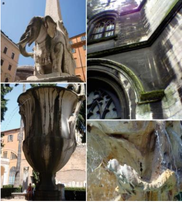
Şekil 10 Yüzeylerdeki renk değişikliği paternleri: (a) Roma şehir merkezindeki Bernini'nin Fil heykeli (İtalya) (b) Brüksel'deki St Boniface kilisesinin ön cephesi, siyah nemli sülfatlı kabuklar ve daha nemli bölgelerde prototrofik biyofilmler. Cephenin en açık ve kuru üst kısmında farklı renkte şeritler bulunur; (c) Terme di Diocleziano ve (d) Roma'da (İtalya) Trevi'nin çeşmesi, güneş korumalı alanlarda mermerde siyanobakterilerin subaerial büyümesi ve sürekli ıslaklık.
