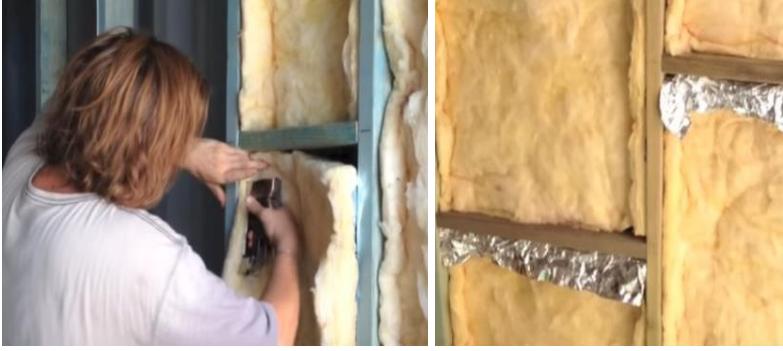
Şekil 4. Konteynerlerde buhar bariyeri ile birlikte taş yünü örtü yalıtımı uygulaması 7
