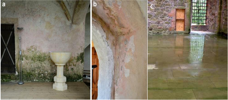
Şekil 4. a) Rappottenstein (Avusturya) kalesinde harç yüzeylerinde yeşil alg ve siyanobakteriyel lekeler. b) Halofilik ve halotolerant arkea ve bakteriler için pembe lekeler (Fotoğraflar: Ettenauer). c) Balçık üreten algler kaygan yüzeylere neden olabilir.
