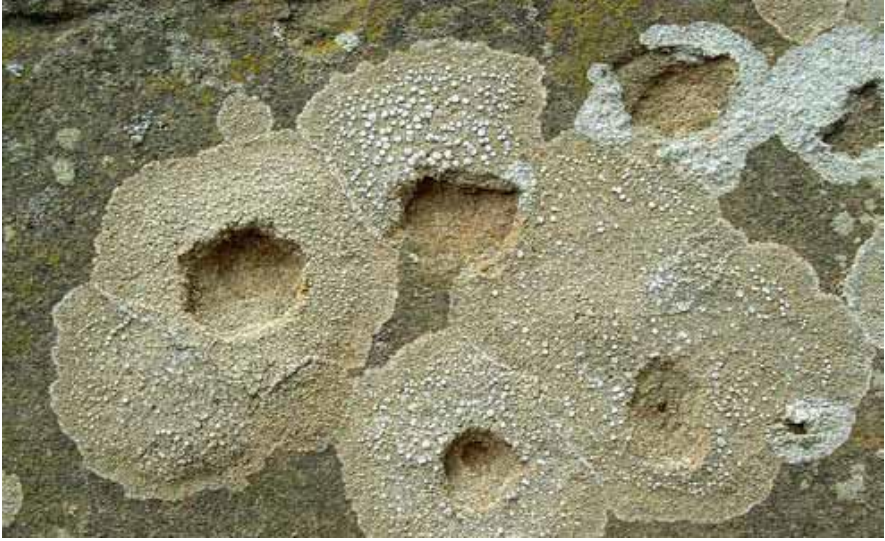
Şekil 2 Liken büyümesinin neden olduğu kumtaşı duvarına verilen nadir hasar örneği
