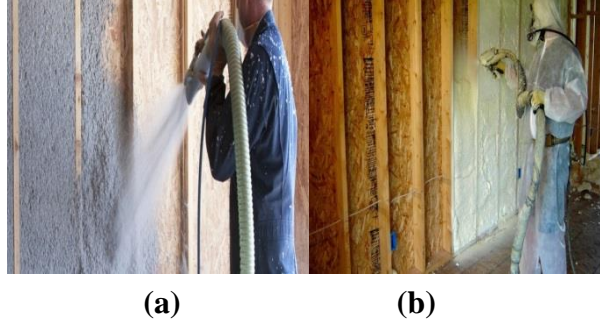
Şekil 2. Diğere sprej yalıtımlar; a) nemli selüloz sprej uygulaması 4 , b) çimentolu sprej köpük uygulaması 5
