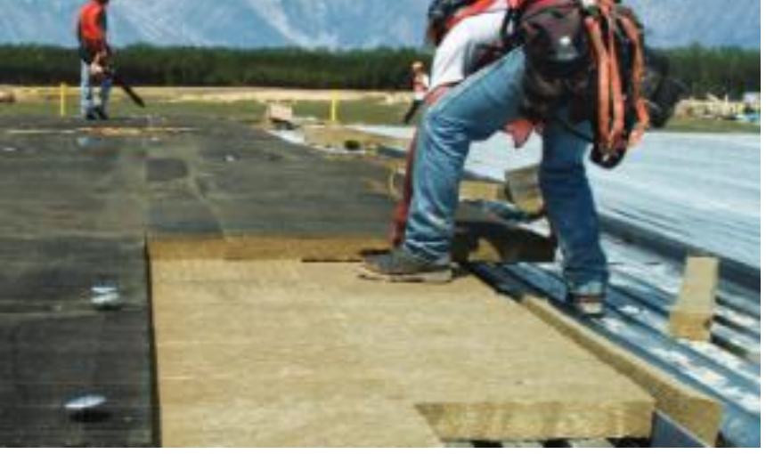
Şekil 5. Konteynerlerde sert mineral yün yalıtım uygulaması 8
