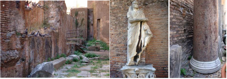
Şekil 9. Roma, İtalya'nın ılıman iklimindeki dış mekân anıtlarındaki fototrofik biyofilmler: (a) Pantheon tapınağının arka tarafında bir Roma duvarının organik besinle zenginleştirilmiş kaya yüzeyleri ve gözenekli harç tabakalarının kolonizasyonu; (b) Mermer bir heykelin üzerindeki siyah şeritler ve (c) Şehrin hava kirliliği olan bölgesinde Terme di Diocleziano'daki bir sütunda lekeler. Nemin yüksek olduğu sütunun arkasındaki gölgeli alanda duvardaki siyanobakterilerin büyümesi
