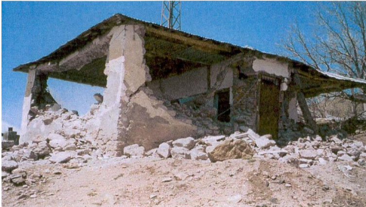
Figure2. Bingöl Earthquake (Karaşin, A.H., Karaesmen, E.)
