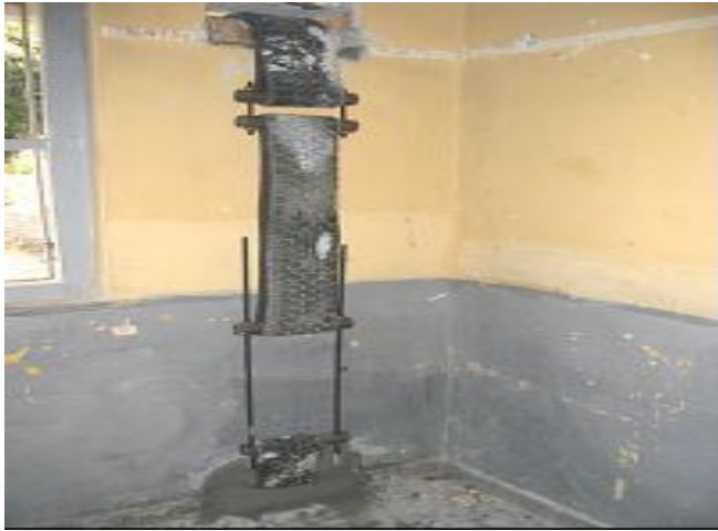
Figure 17. Tensioning of Tires with Chock, Gijon and Nut (Türer, A., Şimşek, Ç., Gölalmiş, M., Özden, B., Dilsiz, A., Özen, Ö., Korkmaz, H.)
