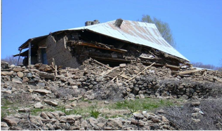
Figure1. Bingöl Earthquake (Karaşin, A.H., Karaesmen, E.)
