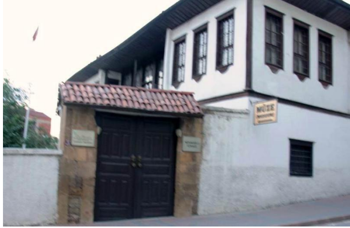
Fot.4,Yozgat Müzesi (Nizamoğlu Konağı) dış görünüm
