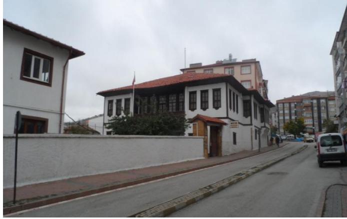
Fot.5,Yozgat Müzesi (Nizamoğlu Konağı) dış görünüm
