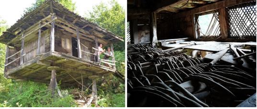
Fotoğraf 3 – 4: Serenderin tahtalardan yapılmış birinci kat döşemesinin alt kısmının ve ağaç dallarından sepet örgü tekniği ile oluşturulmuş döşemesinin üstten görüntüsü.
