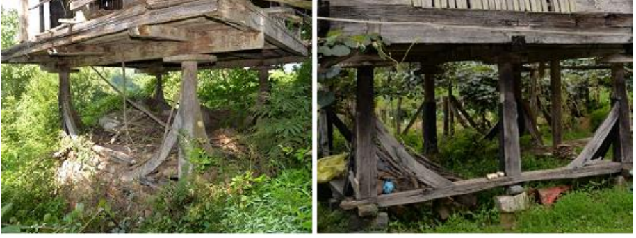
Fotoğraf 1 – 2: Taş malzemeye sahip mütemadi bir temel üzerinde inşa edilen ve her bir direğin birer taş üzerine oturtulduğu münferit temele sahip serender
