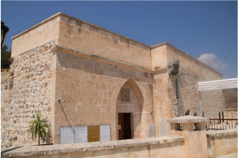
Fot. 3: Ziyaretgâh'ın Doğu Cephesi (M. Çiftiyrek, ASAYİK Arşivinden)
