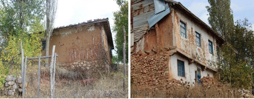
Resim 7-8: Konut Yapı Malzemesi ve Tekniği
