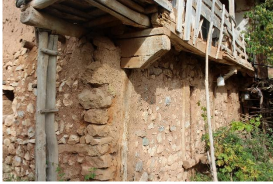
Resim 18: Kıvrımlı Ahşap Payandaların Görünüşü
