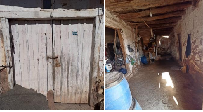
Resim 40: Çift Kanatlı Giriş Kapısı Resim 41: İç Mekan Görünüü
