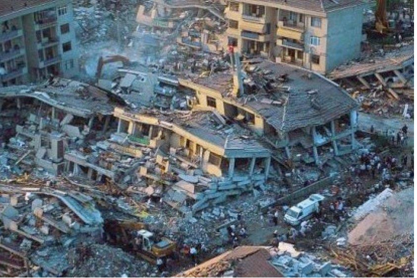
Şekil 2.3: 1999 Kocaeli depremi (Anonim, 2021-5)
