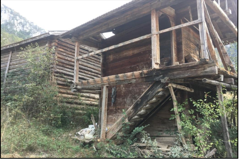
Fotoğraf 47. Ambarların Alt Kısımında Yere Çakılan Dikmeler Ve Üst Kata Çıkmak İçin Kullanılan Merdiven, Nalbantoğlu Mahallesi.
