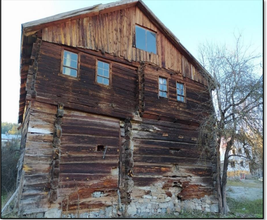
Fotoğraf 24. Oturma Katı Kurtboğaz, Ahır Katı Karaboğaz Geçme Olarak İnşa Edilmiş Geleneksel Mesken, Gümürtler Köyü.
