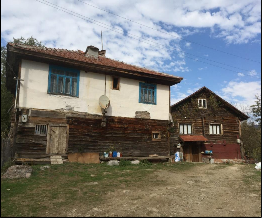
Fotoğraf 27. Dış Yüzeyine Sıva Yapılmış Geleneksel Mesken, Nalbantoğlu Mahallesi.
