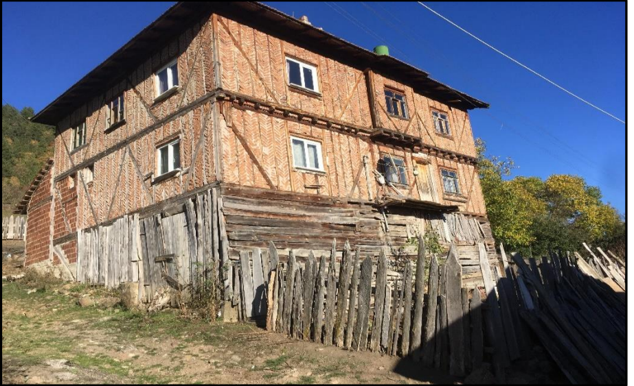
Fotoğraf 26. Ahşap Çatma Tekniği İle İnşa Edilmiş Geleneksel Mesken, Gümürtler Köyü.
