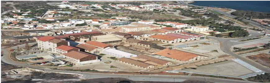
Şekil 4.3 : Restorasyon Sonrası LTCP A Bölgesi Binaları (Url-14).
