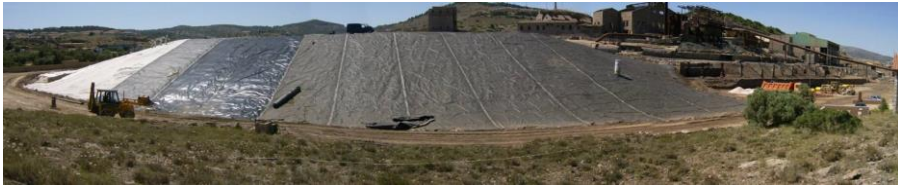
Şekil 4.26 : Atıkların Kil Tabakaları ve HDPE Astarlarıyla Kaplanması (Url-20).
