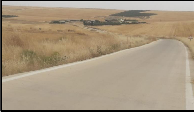
Fotoğraf 10: Yanıkçögür Köyü'ne Giden Yoldan Köyün Uzaktan Çekilmiş Fotoğrafi
