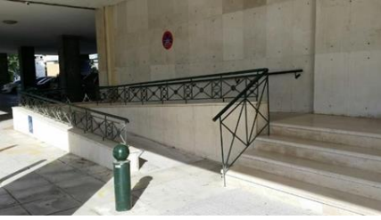
Resim 1: Bina Giriş Rampası
