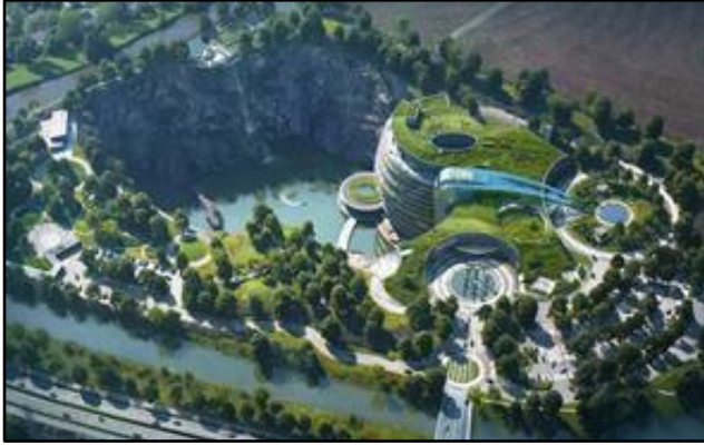
Resim 16. Çatısı ve peyzaj alanı yeşillendirilmiş yeraltı binaları ( https://cutt.ly/5MgpFYG )
