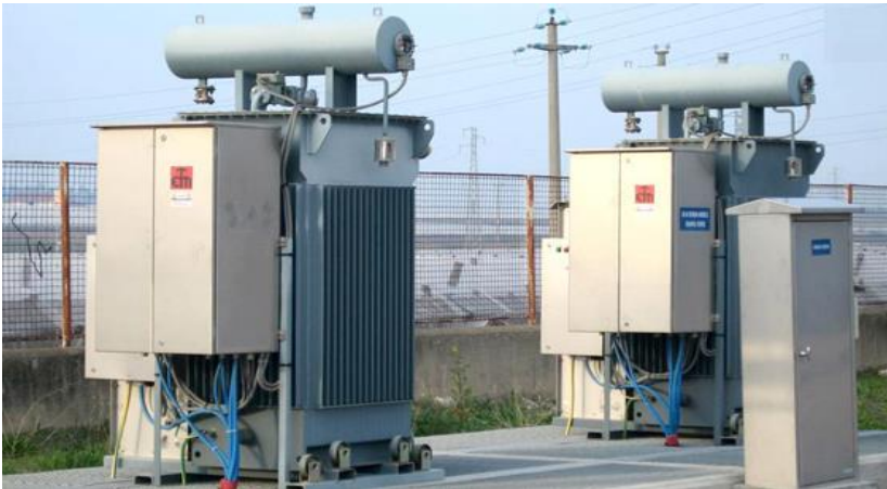
Şekil 5.3. Peterson bobininin uygulamadaki kullanım
