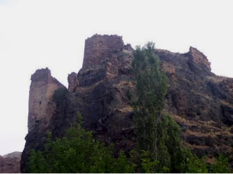
Figür-86 Tekkale Sur Duvarları
