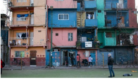
Şekil 8 Villa 31 Cephe Görüntüsü (Url 7, 30.03.2022)
