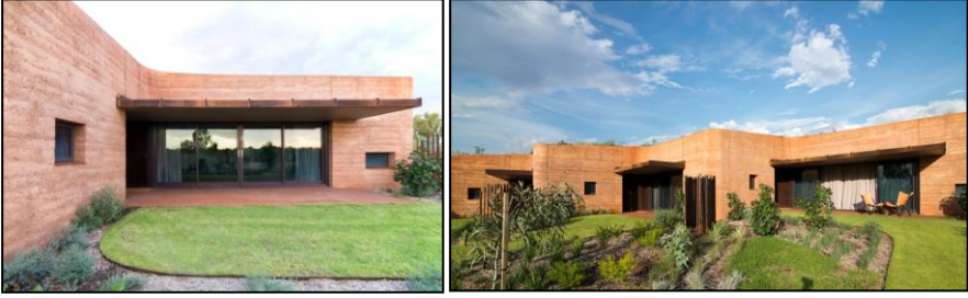
Şekil 2. Yapı girişi (Arch Daily, 2016a)
