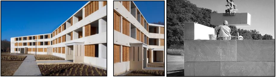
Şekil 34. Perraudin Mimarlık'ın taş duvarlı sosyal konut projesi (Dezeen, 2013a)
