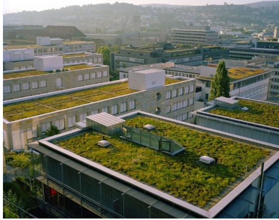
Şekil 2. Almanya’da uygulanmış Yeşil Çatı örnekleri ( Costanzo, 2016)
