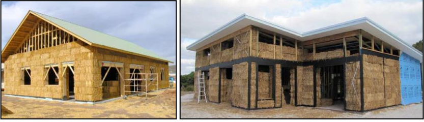
Şekil 17. Saman tuğlaları ile yapılmış evler (Adam, 2018)
