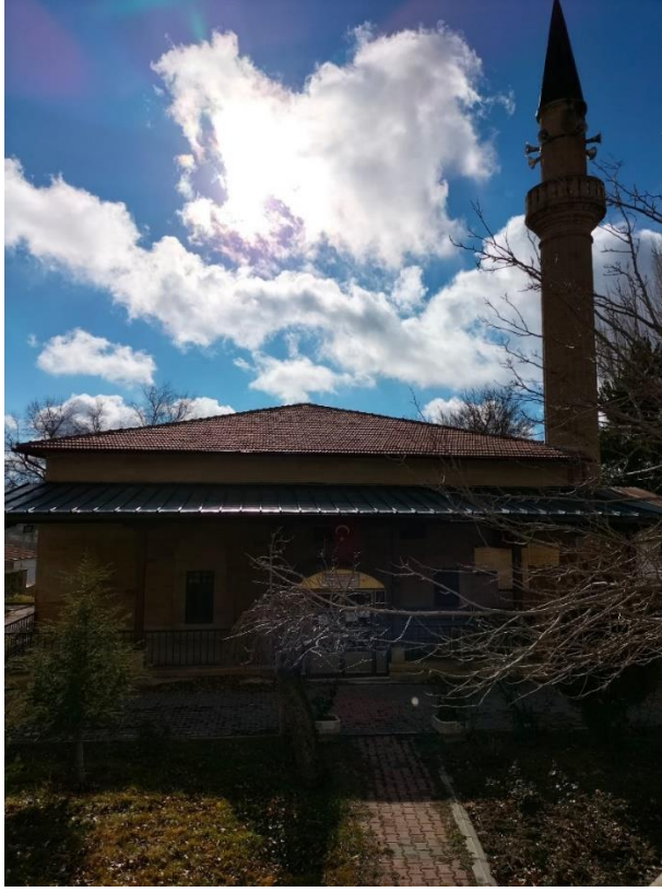
Fotoğraf 2- Kiremit Kaplı Kıрма Çatı Dış Örtüsü
