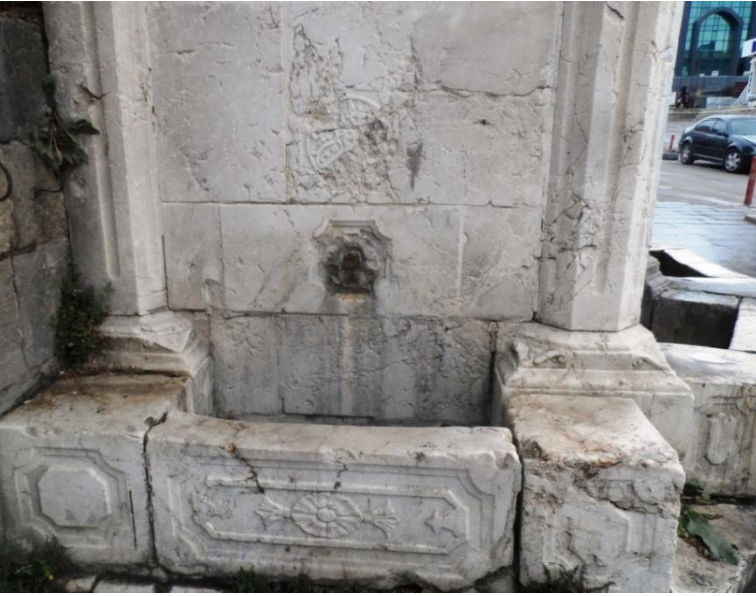
Fot.8, Hamidiye Saatli Çeşmesi güney cephesi
