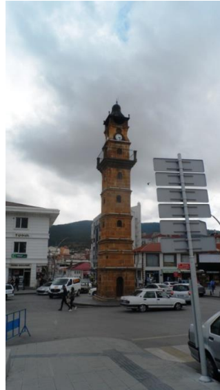
Fot.24, Yozgat Saat Kulesi,Google.dan
