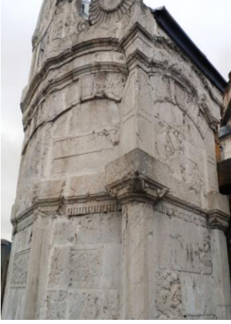
Fot.18, Hamidiye Saatli Çeşmesi güney batı cephesi
