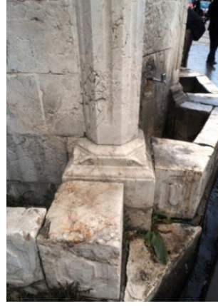
Fot.7, Hamidiye Saatli Çeşmesi güney cephesi
