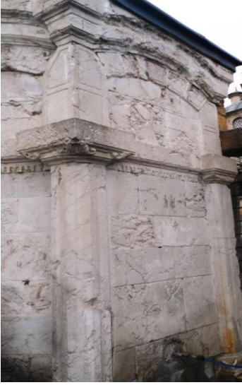
Fot.21, Hamidiye Saatli Çeşmesi güney cephesi
