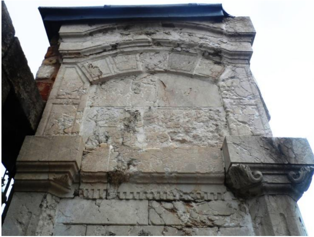
Fot.5, Hamidiye Saatli Çeşmesi güney cephesi
