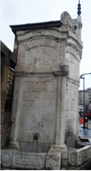
Fot.3, Hamidiye Saatli Çeşmesi güney cephesi
