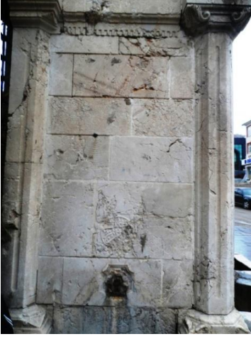
Fot.6, Hamidiye Saatli Çeşmesi güney cephesi
