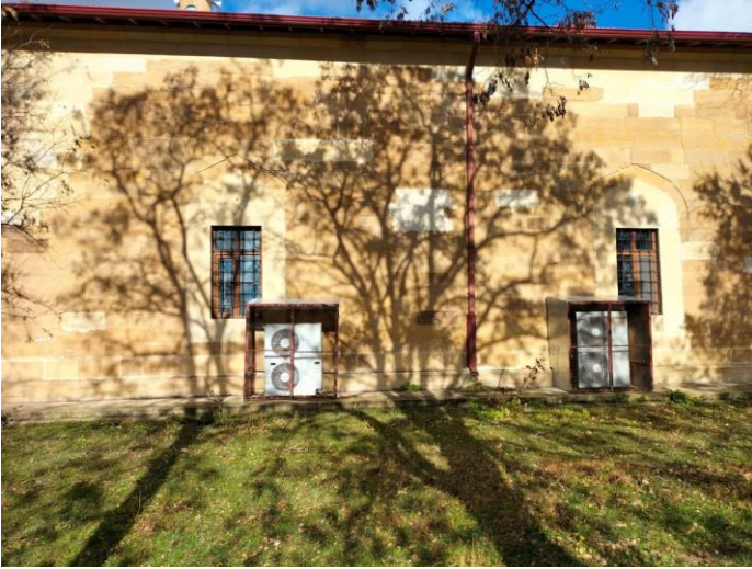
Fotoğraf 4- Güney Cephesinden Görünüm
