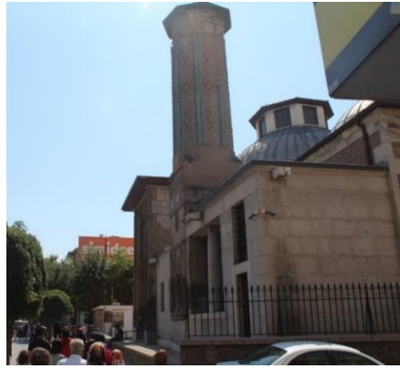
Fotoğraf 26, Minare Genel Görünüm (Havva Güneş 2019-2020 Arşivinden)
