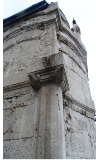
Fot.4, Hamidiye Saatli Çeşmesi güney cephesi
