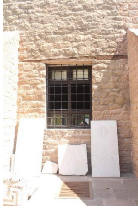
Fotoğraf 16, Batı Cephe Eyvan ve Hatıl Detayı
