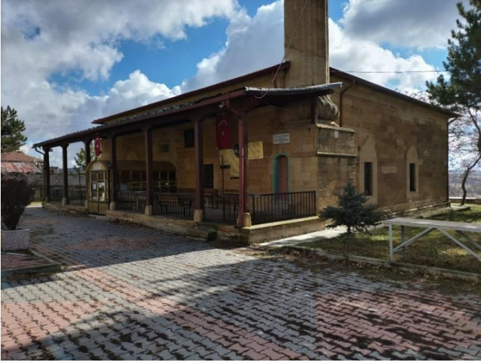
Fotoğraf 3- Batı Cephesinden Görünüm
