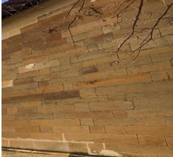
Fotoğraf 11- Cami Malzeme ve Teknik (Sarı Kesme Taş)
