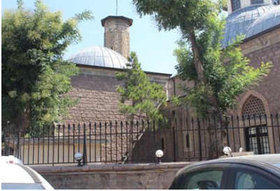
Fotoğraf 17, Kuzey Cephe Genel Görünüm
