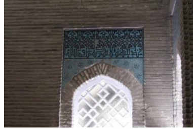
Fotoğraf 39, Güney Duvar
