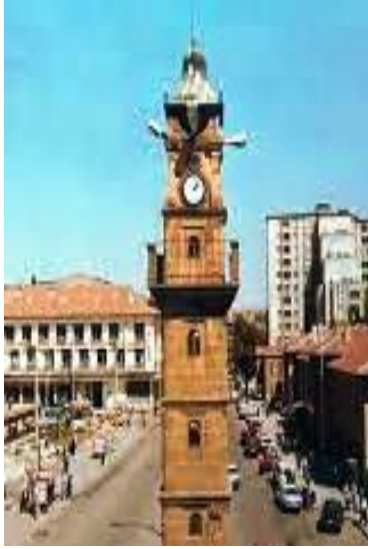
Fot.15, Yozgat Saat Kulesi,Google.dan
