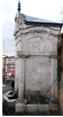
Fot.22, Hamidiye Saatli Çeşmesi güney cephesi
