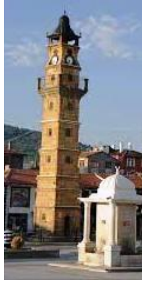
Fot.16, Yozgat Saat Kulesi,Google.dan
