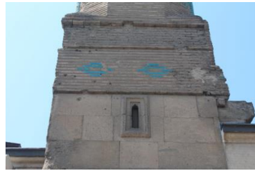
Fotoğraf 27, Minare Pencere Detayı (Havva Güneş 2019-2020 Arşivinden)
