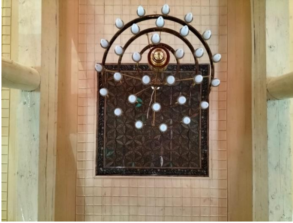
Fotoğraf 23- Ahşap Tavan Göbeği Süslemesinden Görünüm
