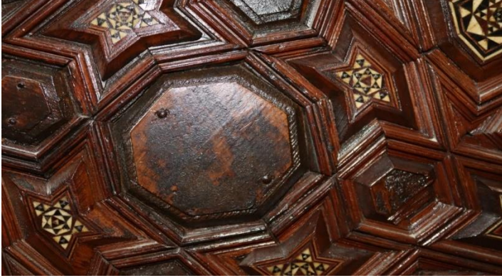
Resim-22: Minber yan aynalık çivi detayı
