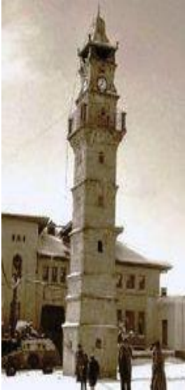
Fot.5, Yozgat Saat Kulesi,Google.dan
