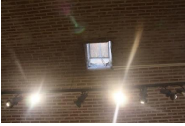
Fotoğraf 65, Kuzey Öğrenci Odası Örtü sistemi Detayı (Havva Güneş 2019-2020 Arşivinden)
