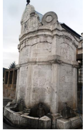
Fot.19, Hamidiye Saatli Çeşmesi güney batı cephesi
