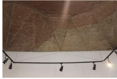
Fotoğraf 56 , Kubbe Geçiş Ögeleri (Havva Güneş 2019-2020 Arşivinden)
