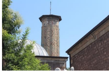
Fotoğraf 24, Minare Genel Görünüm (Havva Güneş 2019-2020 Arşivinden)
