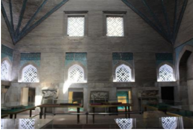
Fotoğraf 46, Avlu Kuzey Duvarı Genel Görünüm (Havva Güneş 2019-2020 Arşivinden)
