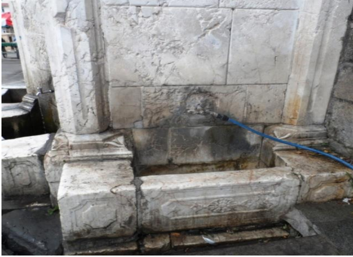
Fot.23, Hamidiye Saatli Çeşmesi güney cephesi
