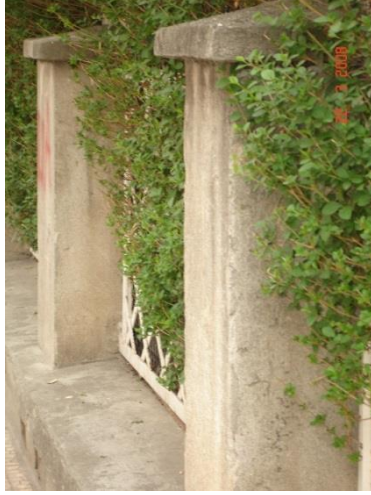
Resim 15. Bahçe Duvarlarından Ayrıntı
