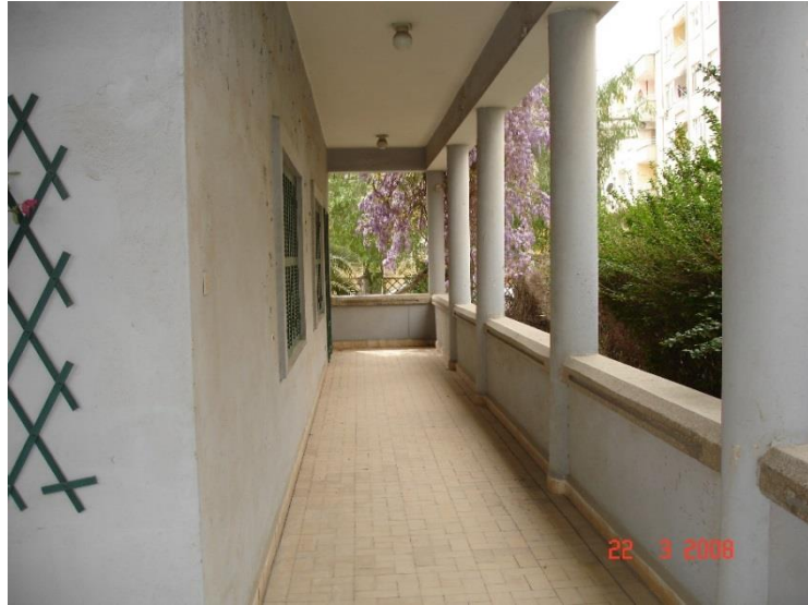
Resim 6. Evin Batı Cephesi Boyunca Uzanan Teras
