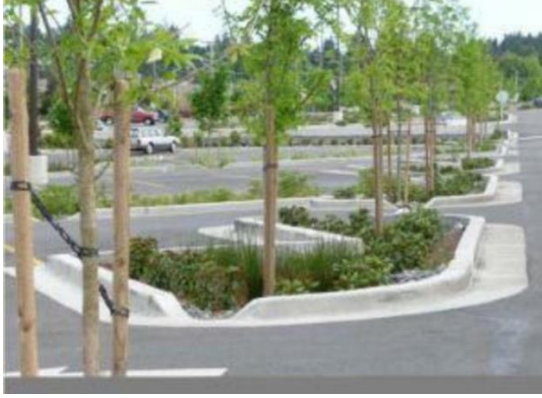
Şekil 7: Yeşil otopark çalışmalarında yeşil altyapı entegrasyonu (Temizel, vd., 2021).
