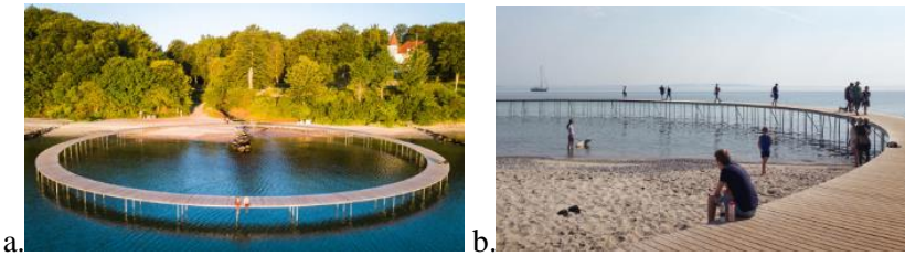
Şekil 16: a. Sonsuzluk köprüsü (Jakobsen, 2018); b. Sonsuzluk köprüsü (Gjøde and Povlsgaard Arkitekter, 2018).
