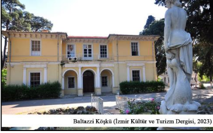
1850-1870'li yıllarda inşa edildi. Sağlam durumda.
