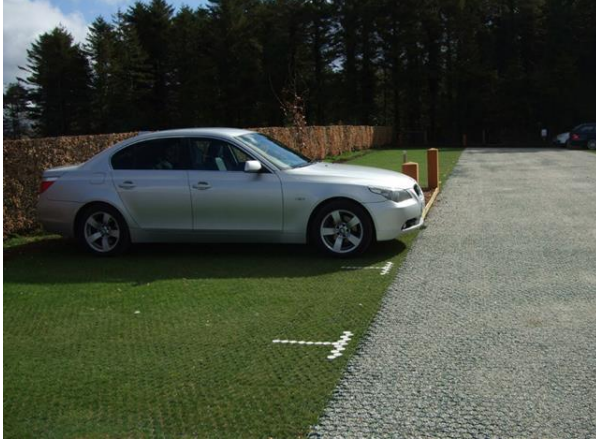
Şekil 8: Yeşil otopark çalışmalarında geçirimli yüzey çalışması örneği (Karakoç, 2014).
