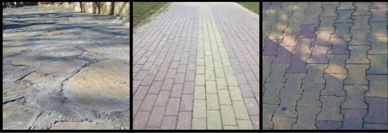
Şekil 7: Saraybosna parkı, kayrak taş, kilit parke taş, dikdörtgen kilit parke taş döşeme (Orijinal, 2018).
