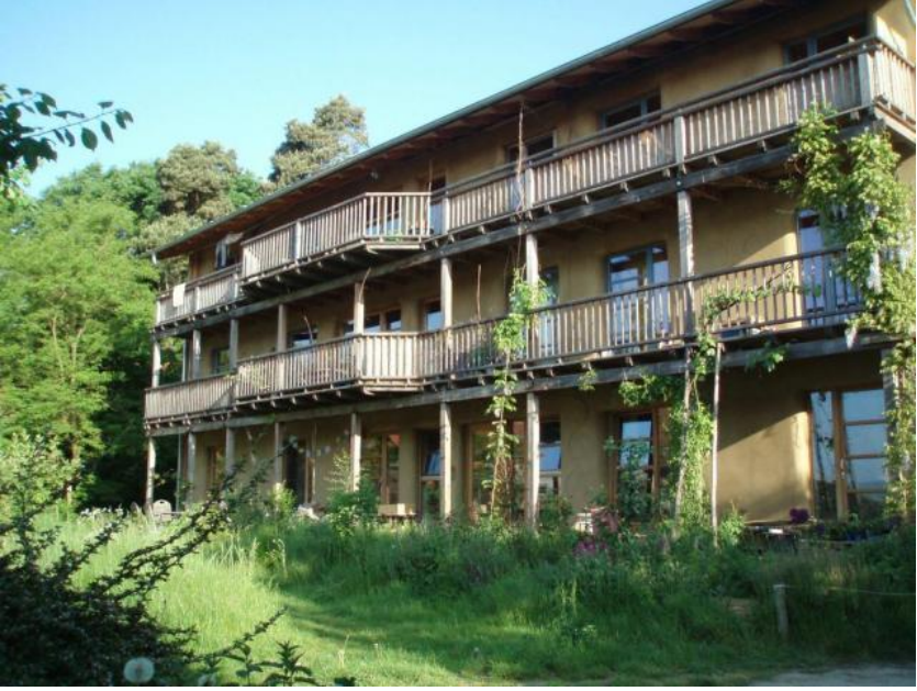
Fotoğraf 59. Sieben Linden Ekoköyü'ndeki "Strohpolis" Evi/Avrupa'nın Saman Balyalarından Yapılmış En Büyük Evi (Andreas, 2012)
