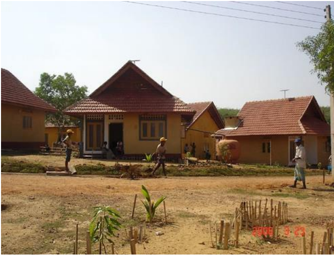
Fotoğraf 5. Sarvodaya Ekoköyü'nde İnşa Çalışmaları-2 (URL-11)
