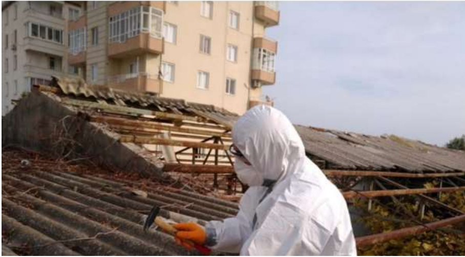
Şekil 7. Yapıda Asbest Kontrolü (URL-6).
