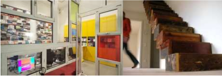
Şekil 81. Solda PVC Doğramaların Kullanılmasıyla Oluşturulan Bir Büro Bölmesi (URL-101), Sağda ise Hollanda’da Ağaç Malzemenin Yeniden Kullanımına Bir Örnek. Ağaç Mobilyadan Merdiven Yapımı. Tasarım: Jan Korbes (URL-102).
