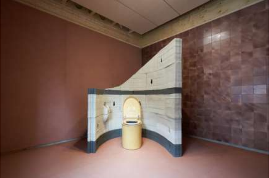
Şekil 106. Çevre Dostu Malzemeden 3D Baskı ile Yapılmış Tuvalet Ünitesi (URL-129).
