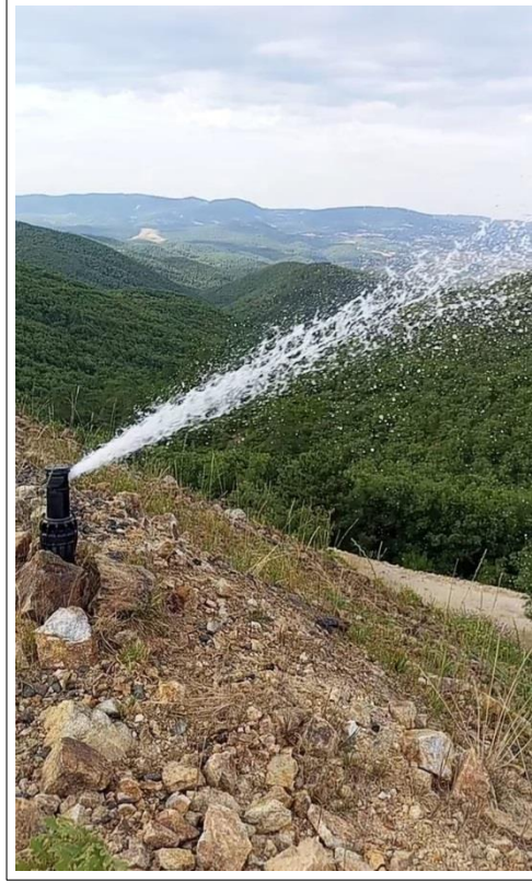
Şekil 31: Şalt Alanı Rotor Sprink Örneği (Orijinal, 2022)
