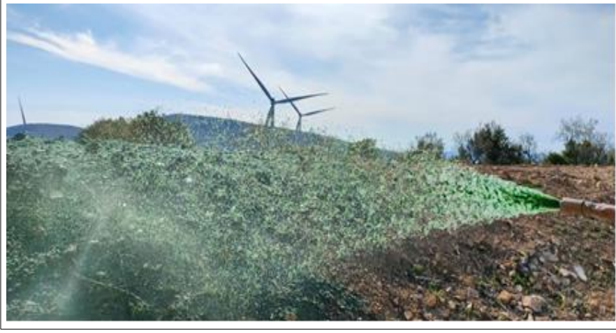
Şekil 20: Hidroseeding Uygulaması (Orijinal, 2021)
