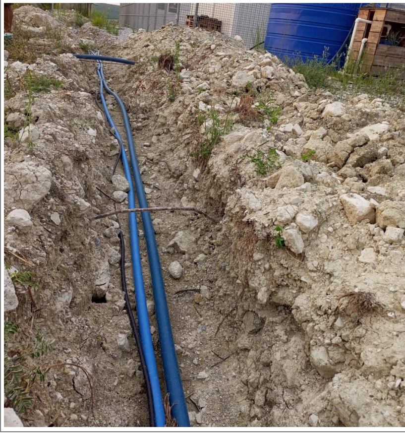
Şekil 32: Şalt Alanı Sulama Sistemi (Orijinal, 2022)
