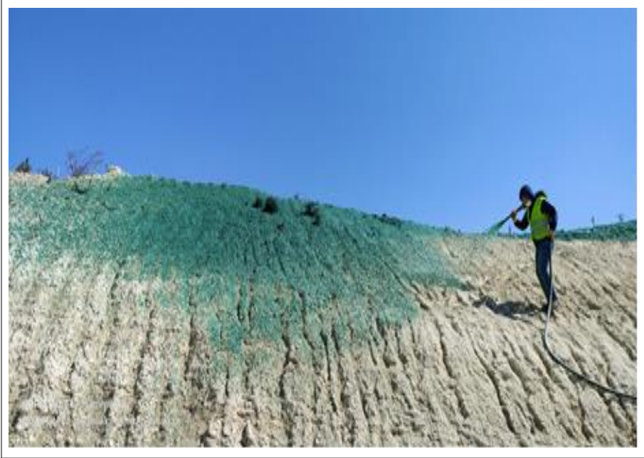
Şekil 17: Hidroseeding Uygulaması ve Makinesi (Orijinal, 2021)
