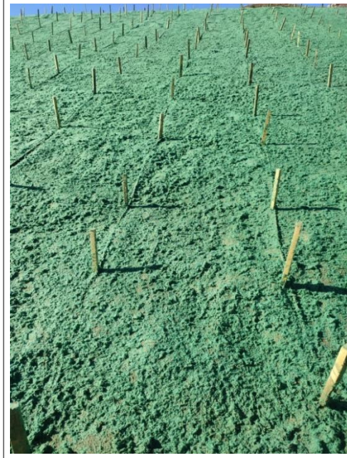
Şekil 24: Dikim Boşluklarına Uygulanan Hidroseeding Uygulaması (Orijinal, 2021)
