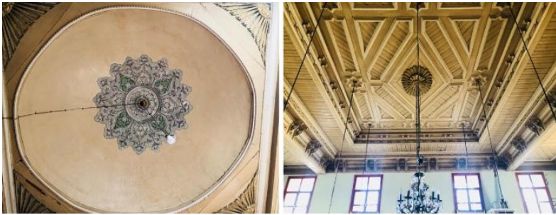
Resim 2.9: Beşiktaş Abbas Ağa Camisi bağdadi kubbe ve ahşap tavan (Alkan, 2019: 311)
