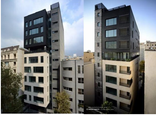
Şekil 2.4.3.1: BM7 Konut Apartman, (Aghazadeh , 2016).
