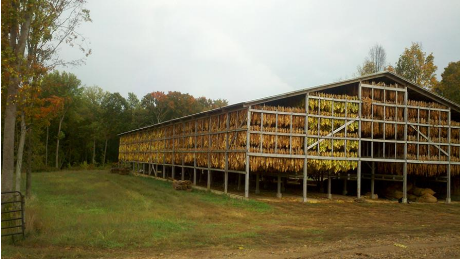
Resim 6. Burley Tütünleri Kurutma Sistemi/Hangarı (Anonim, 2023h)
