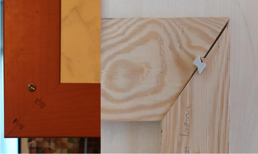
Şekil 151. Bir Mutfak Dolap Kapağında Plastik Kavelalı Gönyeburun Birleşim Çerçeve Konstrüksiyon ve Hatalı Bir Gönye Burun Kesim (Demirarslan, 2023).
