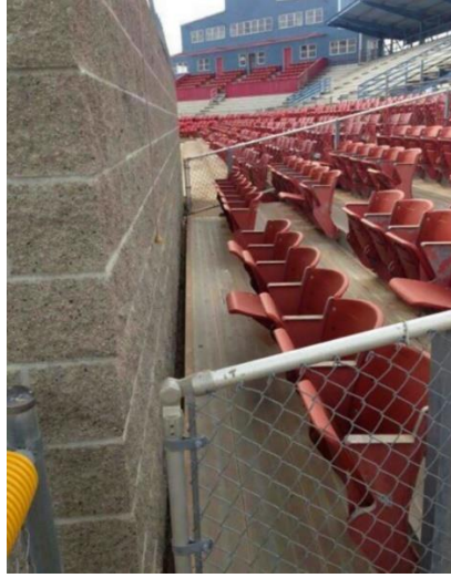
Şekil 18. Mimari Teknik Çizimde Yapılan Dikkatsizliklerin Hatalı Uygulama Sonuçlarına Bir Örnek (78 Architects Who Had One Job And Still Failed, 2016).
