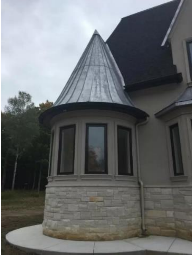
Şekil 68. Eğrisel Yüzeyle Çatının İnce Kesim ve Geniş Yüzeyle Gereç Kullanımı Yöntemleri ile Kaplanması (Lead Roofing, 2023).
