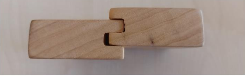
Şekil 136. Başlık- Örtü İlişkilerinin Kurulmasında İçli Dışlı Düz Geçme Yöntemi (Demirarslan, 2005; Demirarslan, 2023). 51
