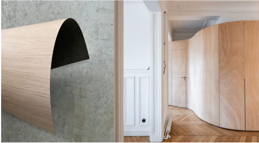
Şekil 69. Lamine Ahşap Malzeme ile Kavisli Duvarların Kaplanması (The Comeback of Curved Design: Materials That Can Bend and Curl, 2022).
