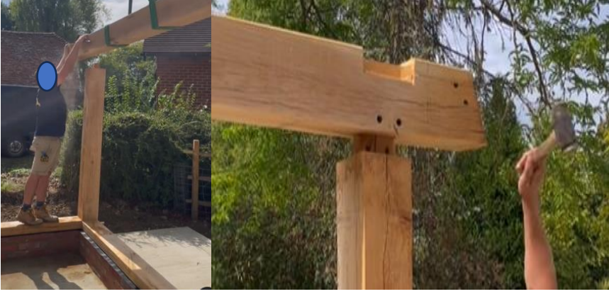
Şekil 125. Ahşap Yapıda Kuşak- Örtü İlişkisinde Düz Geçme Yöntemi (Alh Timber Framing Limited, t.y.)
