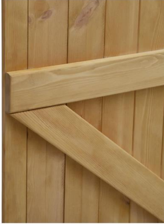
Şekil 132. Başlık- Örtü ilişkilerinin kurulmasında Bindirme Yönteminin Kullanıldığı Bir Bahçe Kapısı Tasarımı ve Detayları (Pine Wood Garden Gate With Latch, t.y.).
