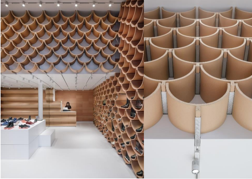
Şekil 202. Camper Paseo de Gracia İç Mekân ve Seramik Parçaların Birleşim Detayı (Camper Paseo de Gracia / Kengo Kuma & Associates, t.y.).
