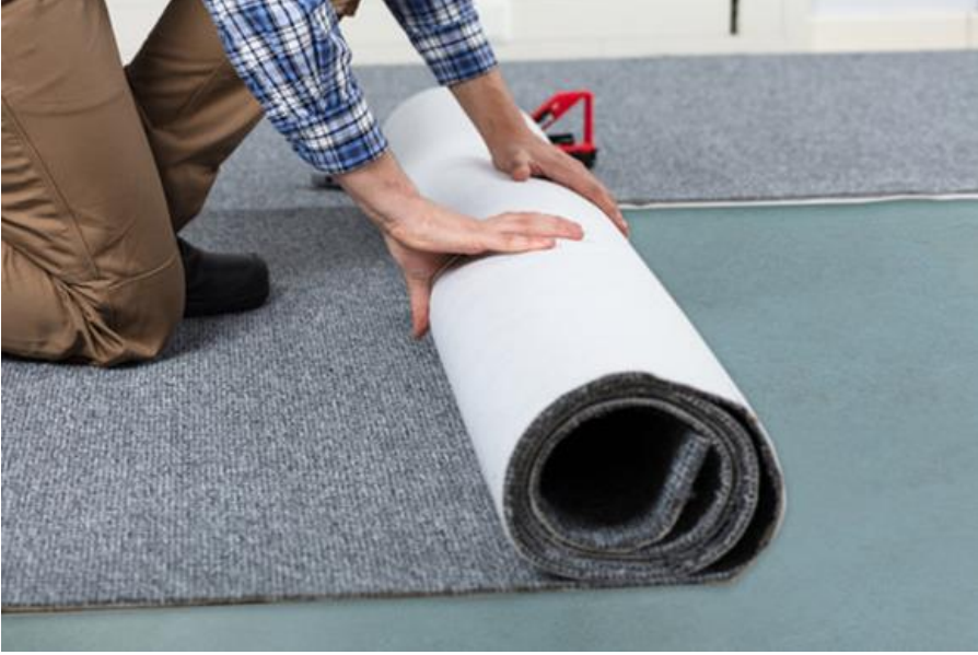
Şekil 42. Rulo Halı Gereç ile Zeminin Kaplanması (Solier Moquettiste, t.y.).
