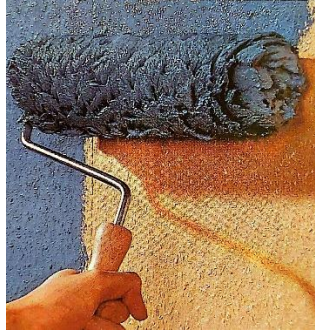
Şekil 32. Sıvı Gereçlerden Boyanın Duvar Yüzeyine Uygulanması.
