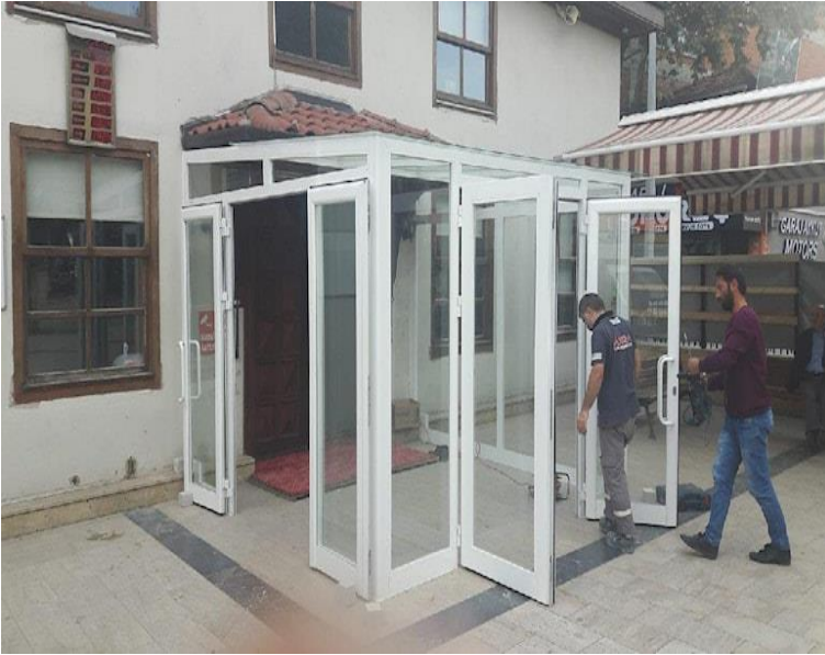
Şekil 30. Tarihi Adapazarı Ağa Camii ve Restorasyon Sonrası Eklentiler (Tarihi Camiye ‘PVC’ Kapı!, 2018).
