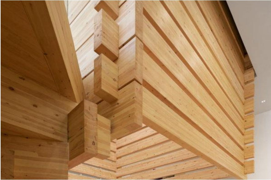
Şekil 200. Kurtboğazi Geçme Sisteminin Odunpazarı Sanat Müzesi Cephesinde Uygulanmasına İlişkin Detay (The Odunpazarı Modern Art Museum, 2019).
