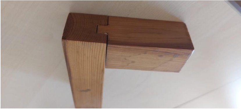
Şekil 155. Kapalı Delikli Geçme Çerçeve (Demirarslan, 2023).
