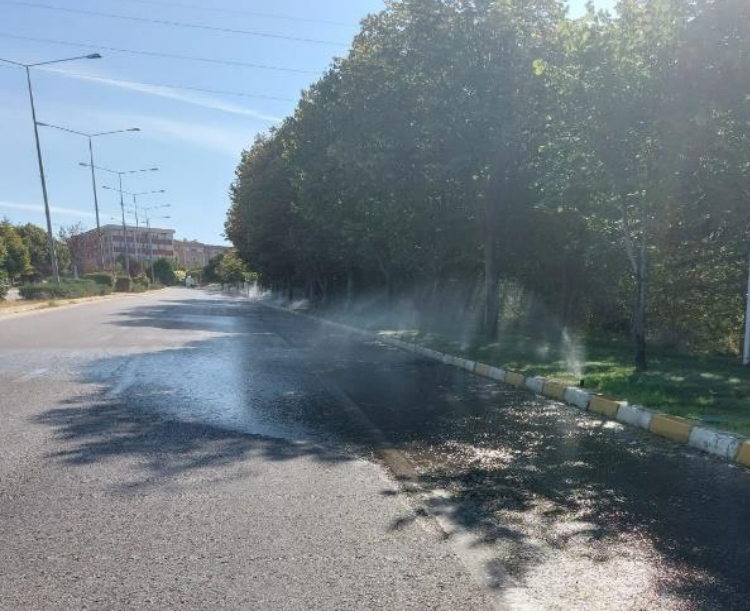
Şekil 4. Hatalı yağmurlama başlığı kullanımı Kaynak: Orijinal (2023)
