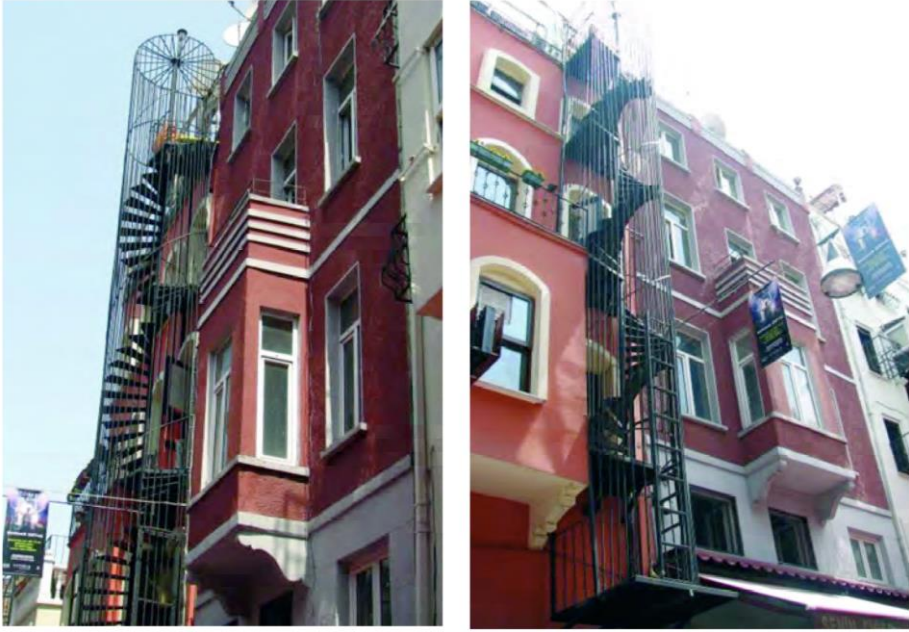
Görsel 20. Yangın merdiveninin cumbanın görüntüsünü kapatması (Arpacıoğlu, 2010).
