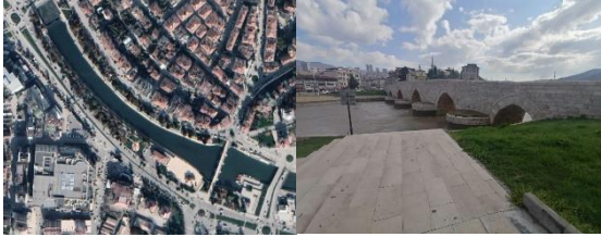
Görsel 8. Tokat Hıdırlık Köprüsü.
