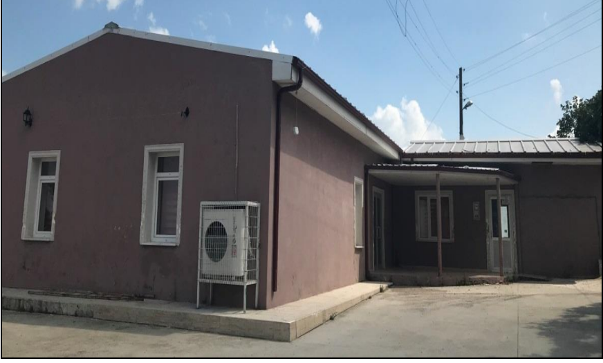
Fotoğraf 55: Tepeköy’de Binası Yenilenerek Düğün Salonu Kültür Merkezi Olarak Kullanılan Eski Bir Kilise
