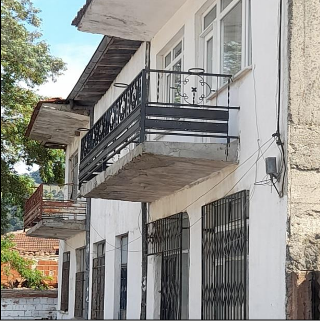
Fotoğraf 93: Yeni Yapılarda Yer Alan Balkon Örneği (Kızderbent)
