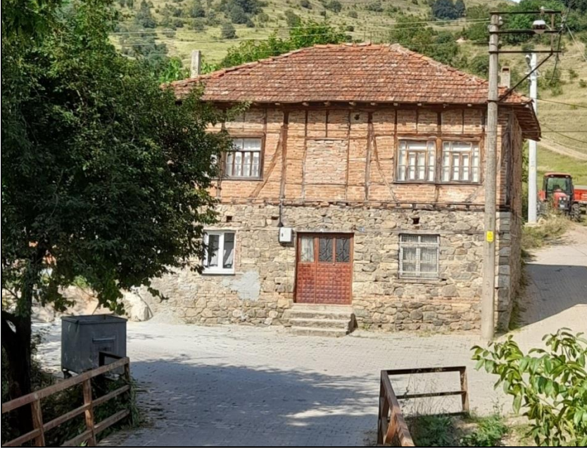
Fotoğraf 88: İki Katlı Taş Blok Üzerine Kargir Yapı Mesken Türü (Kızderbent)
