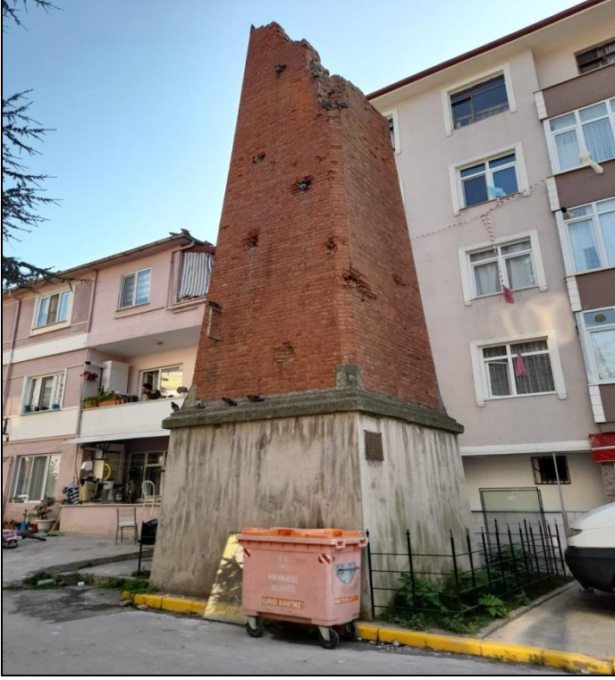
Fotoğraf 11: Karamürsel Dokuma Fabrikası Bacası (Altınkemer)
