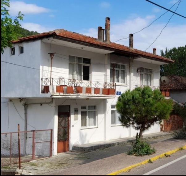
Fotoğraf 94: Yeni Yapılarda Yer Alan Balkon Örneği (Kızderbent)
