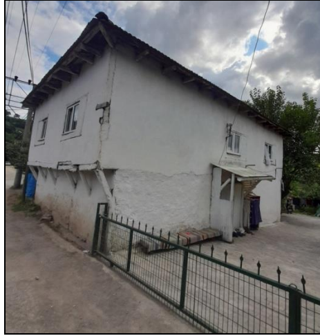
Fotoğraf 57: Kerpiç Malzemedan Yapılan Mesken Örneği (Çamdibi)
