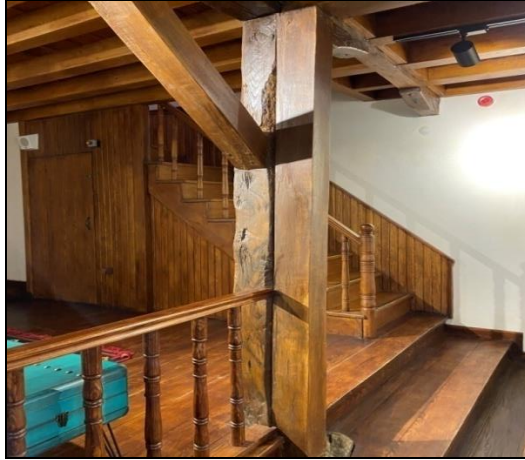
Fotoğraf 98: Eski Yapıdan Kalma Sol Direk, Restorasyon Sonucu Eklenmiş Sağ Direk
