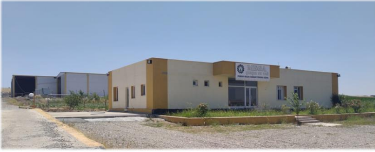
Şekil 1. Çalışma kapsamında incelenen çırçır fabrikası
