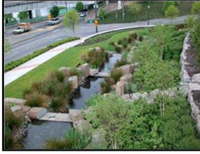
Őekil 2: Oregon, Portland, Convention Center'in çatısından akan suların kentin kanalizasyon sistemine karışmadan yeraltı sularına sızmasını sađlayan yađmur bahçesi ( Url-3 )
