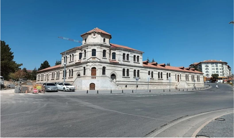
Őekil 10: Tarihi Jandarma Binas (zgn)
