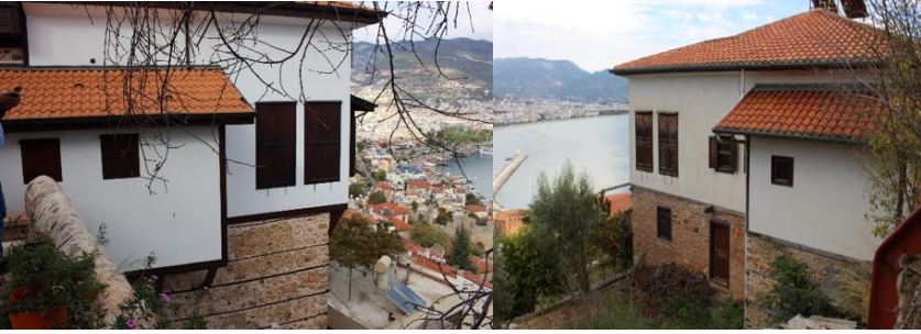
Şekil 11. Eliböğüründe ile taşınan tuvalet örneği (solda), zemin kat taş duvar örülmüş örnek (sağda) (Tophane/ALANYA)
