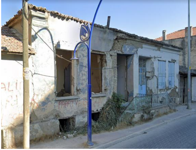
Resim 7. Muradiye’de bulunan bodrum+1 katlı, atıl durumdaki tescilli yapılar
