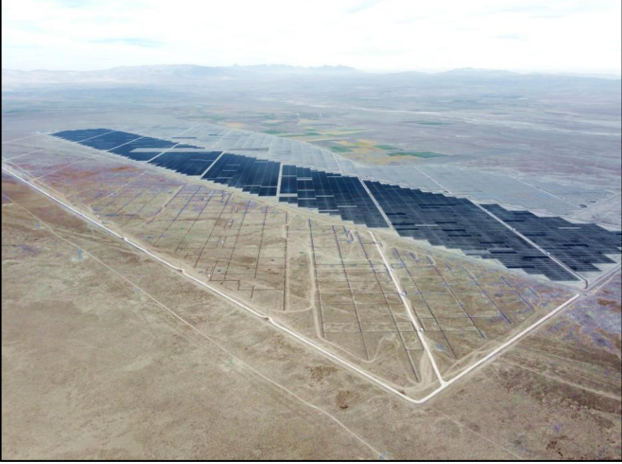
Fotoğraf 67: Bor Ovası Eymen Köyü Yakınlarında GES Panelleri Kurulumu
