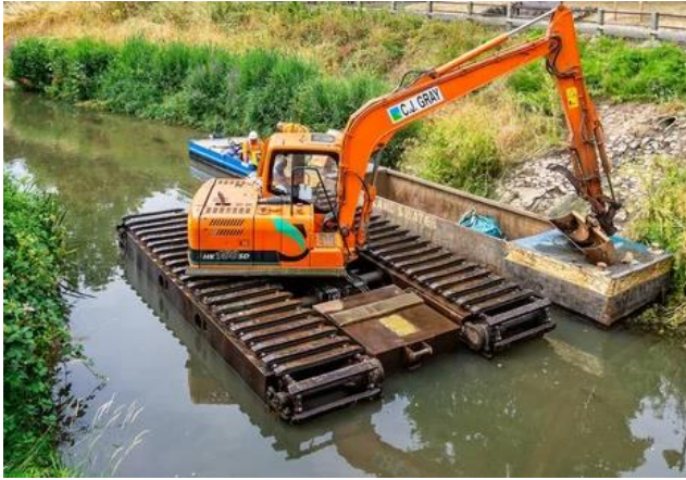
Şekil 9. Kanalların derinleştirilmesi ( https://depositphotos.com/tr/photos/dredging-river.html )
