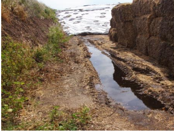
Şekil 1: Drenajı Kötü Olan Bir Bank Tipi Silo Zeminini, Sızıntı Suyunun Silo Alanında Kalmasına Neden Olmakta, Yumuşak Zemin İse Makine İzleri Oluşmasına İzin Vererek Sorunu Şiddetlendirmektedir (Davis, 2021)
