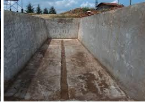
Şekil 2: Beton Duvarlı Silo (Anonim, 2023b)
