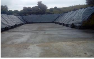
Şekil 1: Toprak Duvarlı Silo (Anonymous, 2023a)
