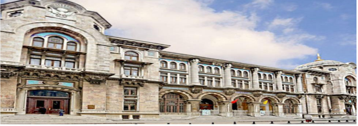
Resim 44. İstanbul Merkez Postanesi (Sirkeci Binası)
