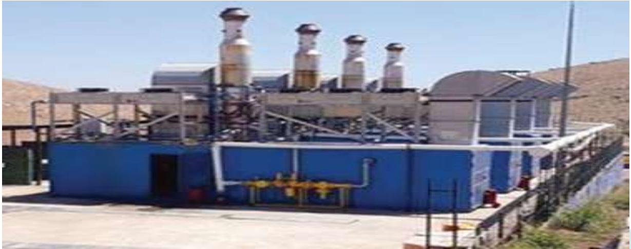
Şekil 1: Şanlıurfa Büyükşehir Belediyesi Katı Atık Arıtma Tesisi
