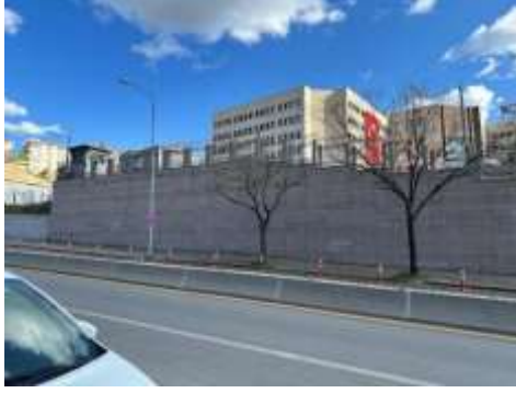
Şekil 13. Emniyet Genel Müdürlüğü sınır elemanı/ duvar
