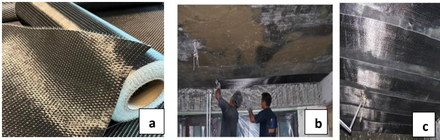
Şekil 4 a) CFRP ile güçlendirmek (Pehlivanlı M., 2023) b) Döşeme düzeyi c) CFRP ekledikten sonra (Hsu, 1756)
