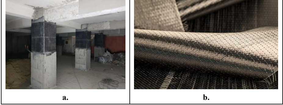
Şekil 4 a. Kolonun lifli polimer (LP) ile sarılması b. LP örneği 5
