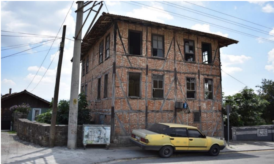
Fotoğraf 7. Bağbadi Tekniği ile Yapılmış (Hımış) Mesken (Konurlap).
