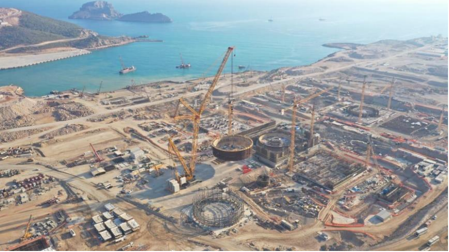
Şekil 1: Akkuyu Nükleer Güç Santrali Yapım Aşaması
