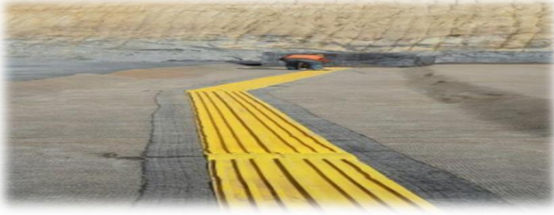
Şekil 8. Temel dilatasyonunda su tutucu bant uygulaması (Altaş, 2018)
