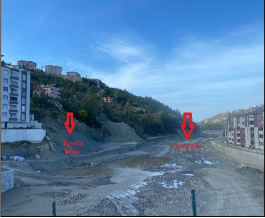
Fotoğraf 2: Ezine Çayı Kenarında Yamaç Bozulması Sonucunda Gerçekleşmiş Heyelan.
