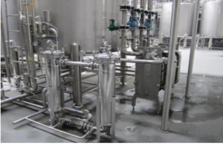
Şekil 86. Plakalı Soğutucu (Kaynak: Beyond, 2024)
