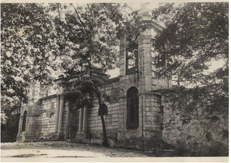
Figure 36: Gulhane Side Facade and Western Tower (Koruma Kurulu Dosyası, 1968)
