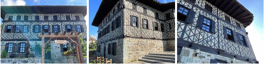
Figure 12. Hacı Yakupağaoğlu Mansion Facade Visuals (Dara Yökünç, 2024)
